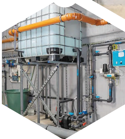
Koncová část technologie: Částečné odsolení a druhá dezinfekční bariéra
